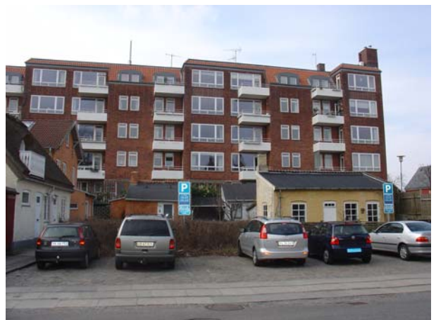
Et pudsigt sammenstød af nyere etagebyggeri mod "lilleput"-husene. Her Taarbæk Strandvej 83 – 89.
