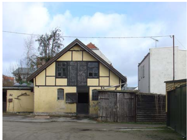
Staldbygningen i 1½ etage forudsættes nedrevet.
